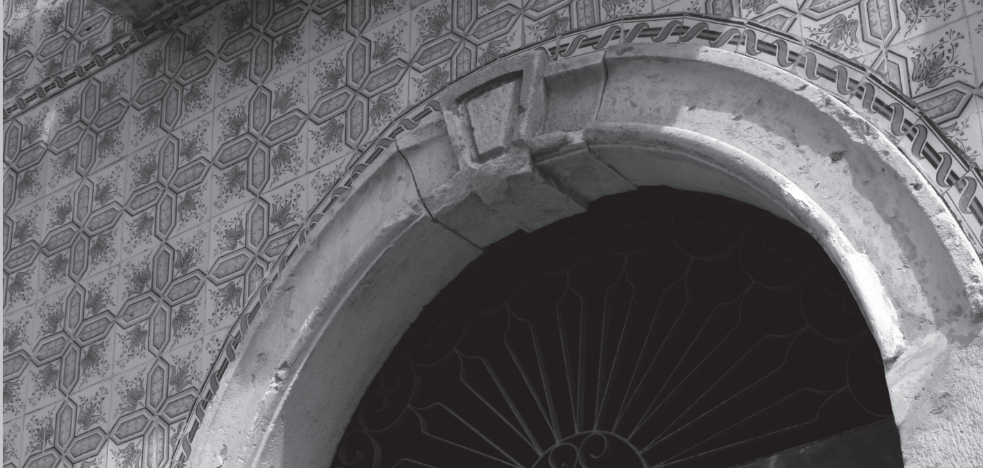
Fachadas azulejadas, como a da Casa do Divino, não podem receber placas fixadas sobre os azulejos.
